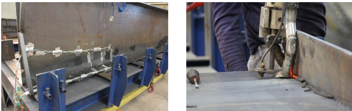
Figura 26 - Fotografias do processo de soldadura G01+G02, à esquerda a instrumentação utilizada e à direita durante o processo
