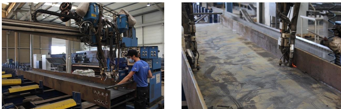
Figura 27 - Fotografias do processo de soldadura G07 + G08, à esquerda uma Vista Global e à direita um pormenor do processo
